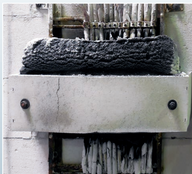
Abb. 3: ZZ W20 nach der 90-minütigen Brandbeanspruchung nach Einheitstemperaturkurve (ETK)
